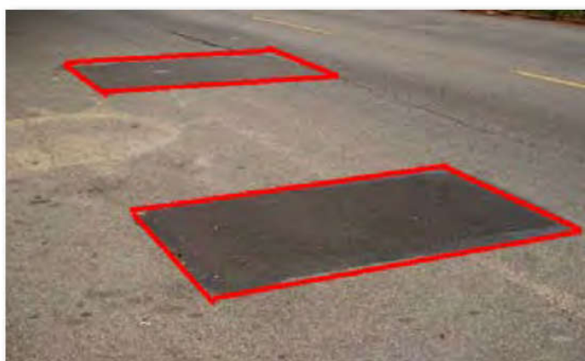
ภาพที่ 2. 4 ลักษณะและประเมินความเสียหายของความเสียหายประเภทรอยปะซ่อมที่เสียหาย
