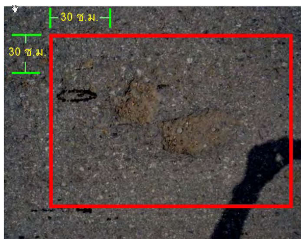
ภาพที่ 2. 3 วิธีการประเมินความเสียหายประเภทหลุมบ่อที่เกิดเป็นกลุ่ม
